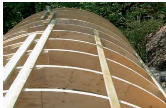
**KERTO Q** besteht aus einzelnen Furnierschichten, die längs und quer zur Plattenlängsrichtung angeordnet sind und kann als Platte, Scheibe oder Träger in den verschiedensten Tragwerken eingesetzt werden.
